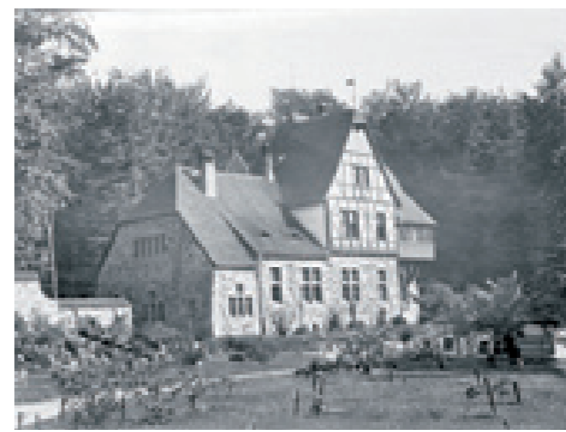
↑ Bild Inspektorenhaus undatiert.
